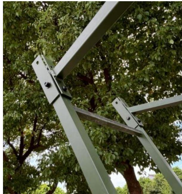
G.) Schritt 7 Befestigen Sie Teil J mit 4 Schrauben Nr. 2 an den oberen Beinen (Teil A), dann befestigen Sie Teil J mit 2 Schrauben Nr. 5 an Teil M.
